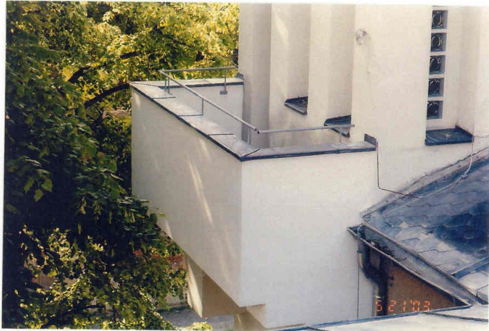
Balkon nach der Sanierung
