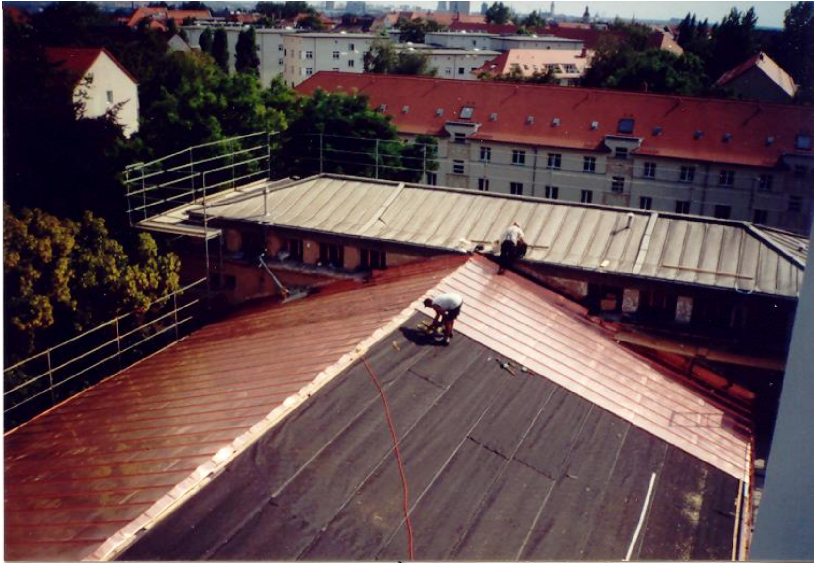
Sanierungsarbeiten am Kirchendach im Sommer 2004
