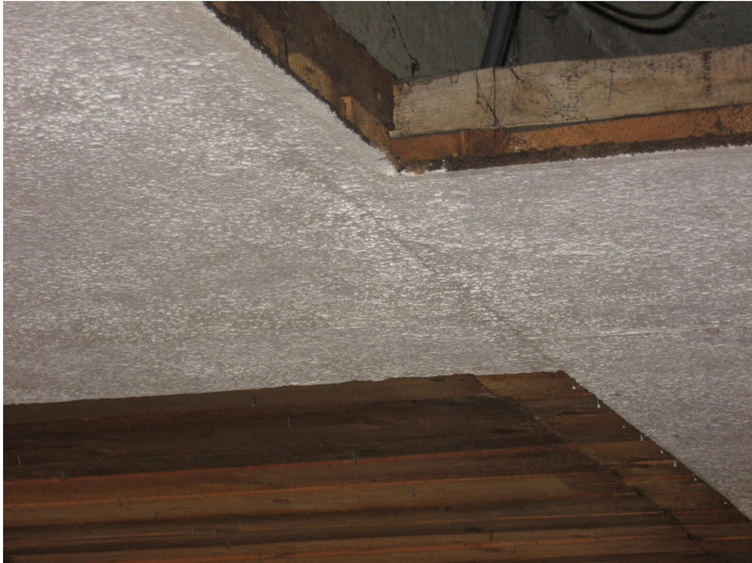
Bereich Saalempore, Befestigung der Celotex-Platten, Lichtkanäle über Empore
