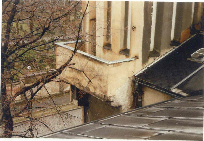
Balkon vor der Sanierung
